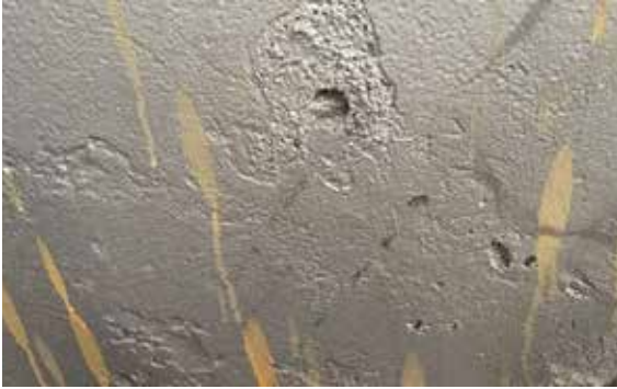
Şekil 12b: Üst kısımdaki kum inklüzyonları
