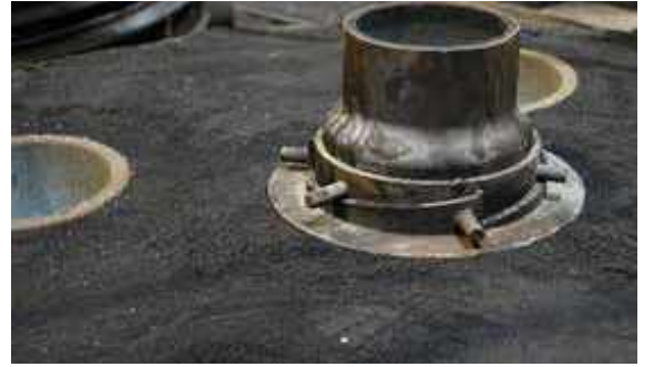
Şekil 5b: kalıbın üstünde kaldırma sistemi
