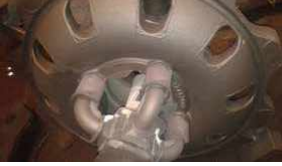
▲ Şekil 12a: HOLLLOTEX Shroud ile tekerlek gövdesi çatlaması
