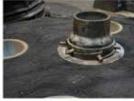
Şekil 5b: Kalıbın üstünde kaldırma sistemi
