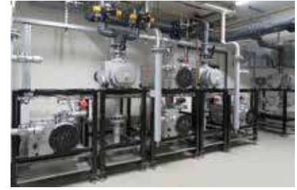
Fig 9: Merkezi vakum sistemi
